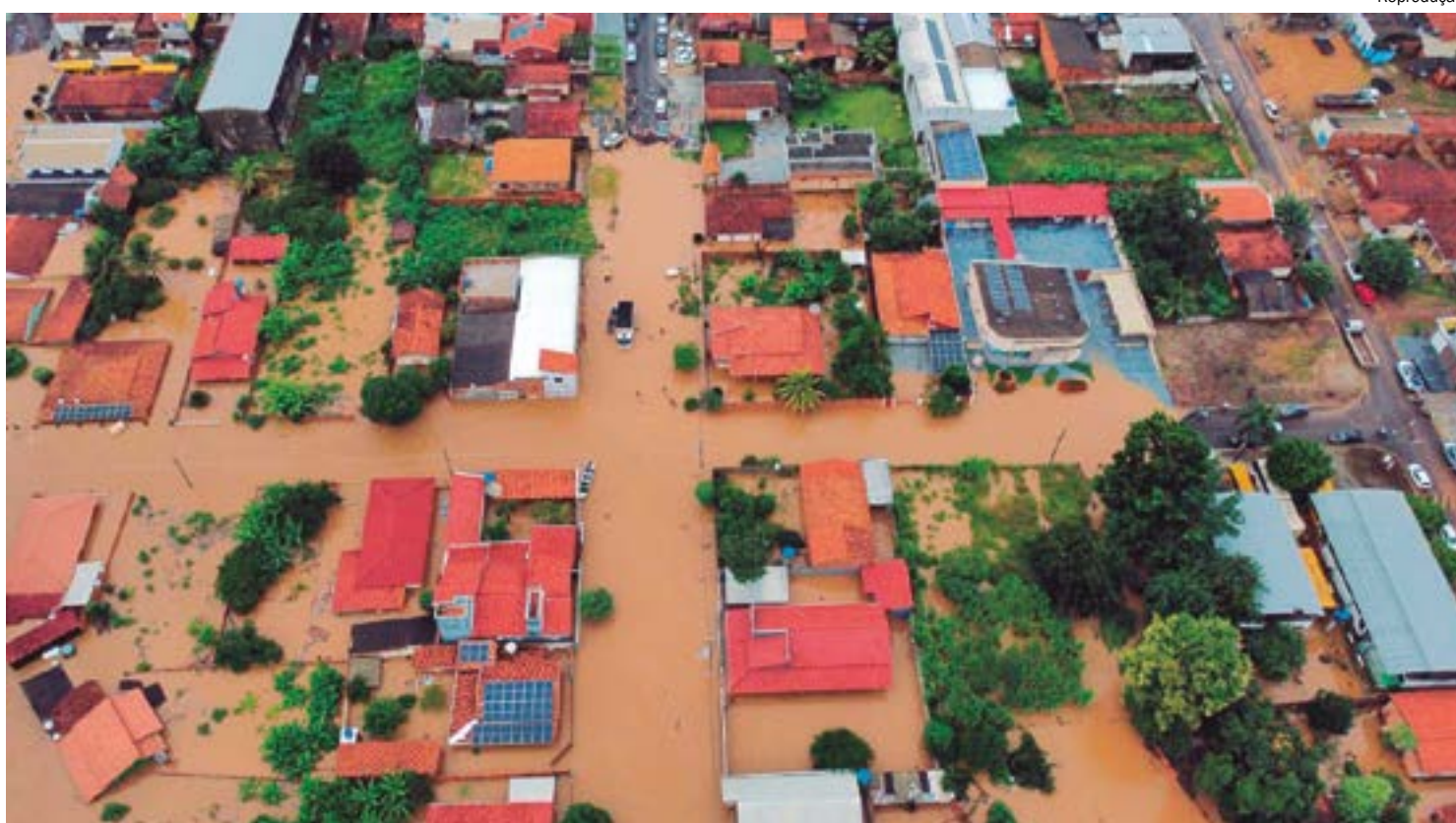
Mauro prometeu apoio para reconstrução de pontes e de 35 casas destruídas pelas enchentes
