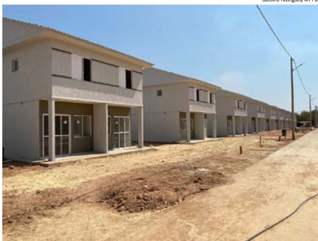
Residencial Gran Pietra, no Pedra 90, está em construção e as unidades fazem parte do SER Família Habitação
