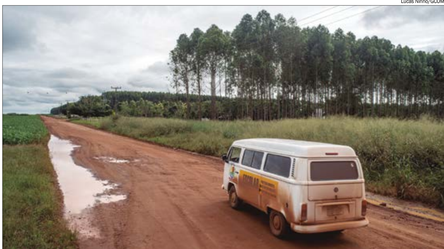
A obra vai asfaltar 120 km em um contorno da Terra Indígena Xavante Marãiwatsédé
