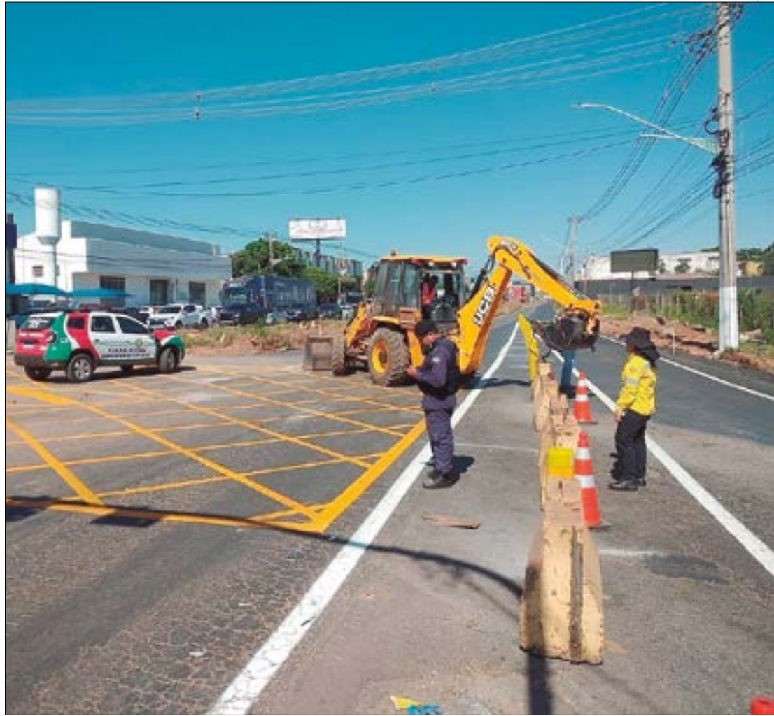
Medidas buscam dar maior fluidez no tráfego durante as obras de readequação da pista
