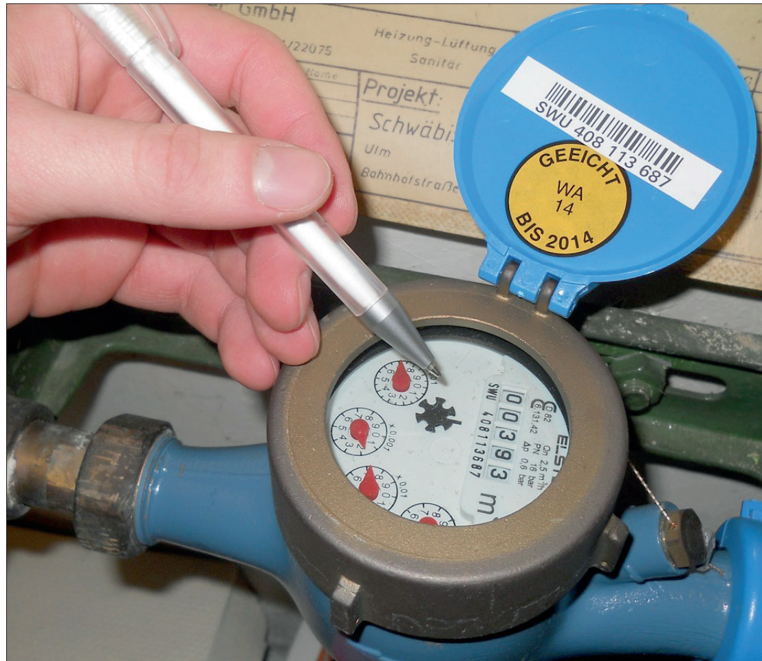
Nos próximos dias obras devem ser lançadas para melhorar o sistema de abastecimento de água e tratamento de esgoto
