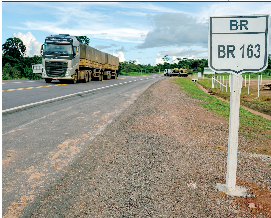
Prefeitos apontam que trecho não duplicado da BR-163 se transformou em 'corredor da morte' e querem assumir a concessão
